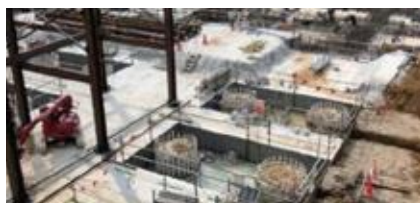
（基礎工事の様子）
