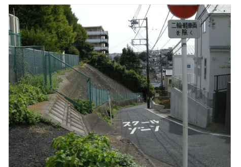
西区側敷地 西側前面道路
